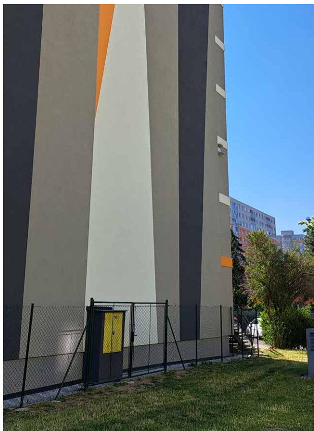
Ploty před plynovými rozvaděči chrání před sprejery, proti jejich nevyžádanému umění je ošetřena i fasáda.
