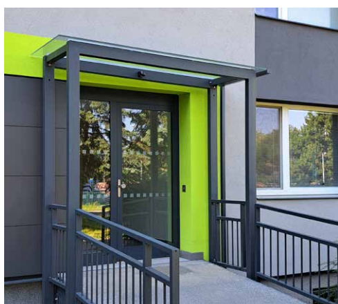
Výhodou vstupního portálu je stříška nad dveřmi a zábradlí, které ocení zejména senioři.
